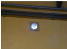
Foto 5. Hueco de ventilación
