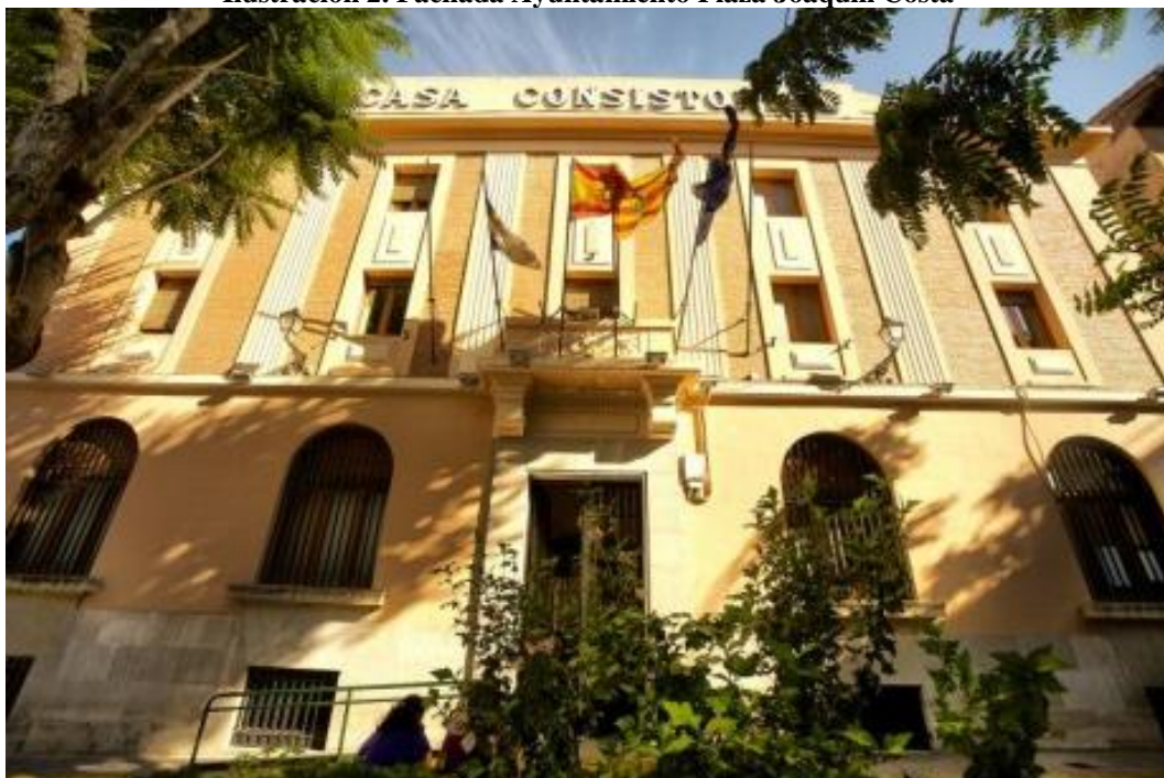
Ilustración 2. Fachada Ayuntamiento Plaza Joaquín Costa
