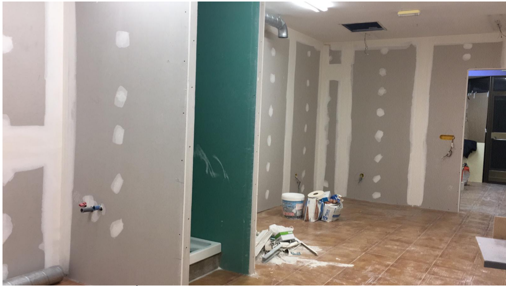
Ilustración 13: Área intermedia durante las obras del mes de Noviembre
