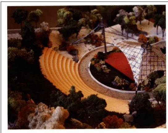
La cubierta está formada por una serie de teselas sujetas por una red de cables que se comportan de forma análoga a una membrana. En el TFG se simulará su comportamiento con una membrana cuyas propiedades deberán determinarse previamente comparando los resultados de las simulaciones con los datos que figuran en la memoria del proyecto original.
