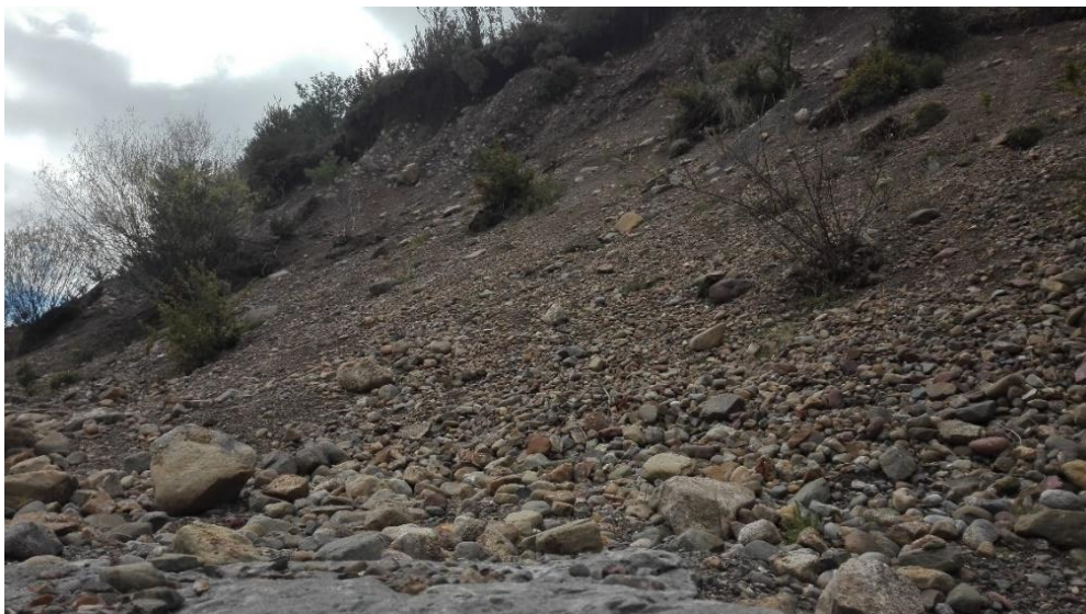
Figura 42: Superficie del talud de la Casa Rural L'Orache. Fuente: Elaboración propia
