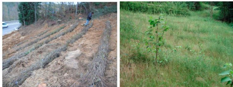
Figura 91: Restauración del talud de la N1 en Etxegarate con fajinas de drenaje. Fuente: (Sangalli, P., 2010)
