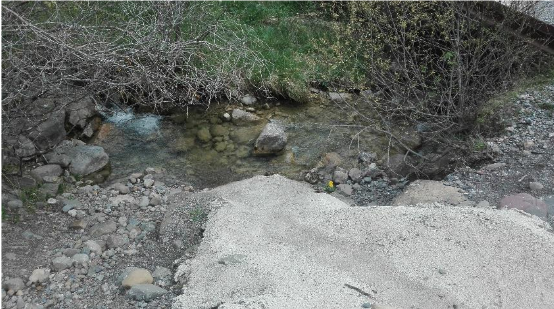
Figura 72: Desembocadura al barranco de la cuneta de la escollera. Fuente: Elaboración propia.
