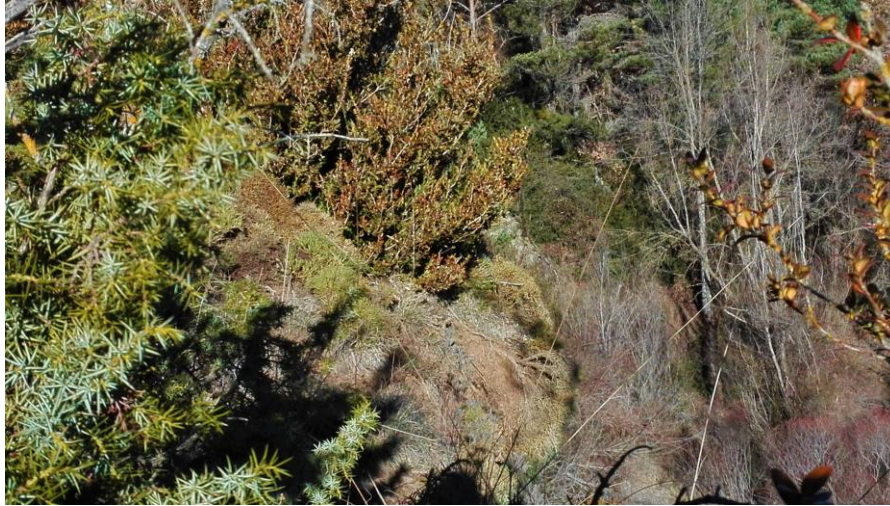
Figura 97: Erizón cohesionando la tierra en la cabecera del talud. Fuente: Elaboración propia.
