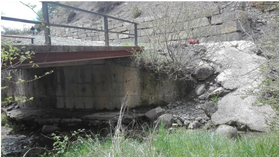
Figura 25: Situación del talud frente al barranco. Fuente: Elaboración propia
