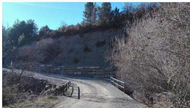
Figura 58: Talud. Fuente: Elaboración propia
