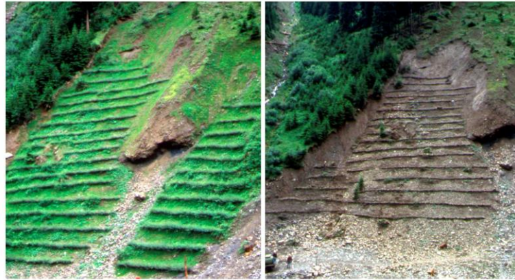
Figura 92: Restauración de un talud con peldaños de leña en Bolzano (Italia). Fuente: (Florineth, F., 1995)
