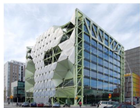
Figura 28: Edificio Media TIC Fuente: [18]
