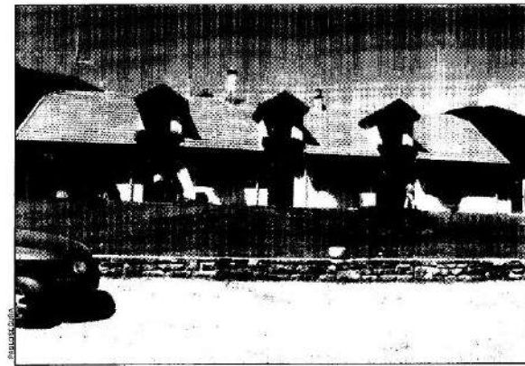
El edificio de recepción del camping "Las Nieves" a demás de vivienda de su propietario, Luis Berde, quedó intacto, a pesar que el agua y las piedras.
