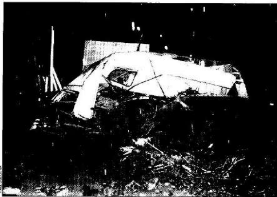
La riada destruyó el camping y una gran residencia.
