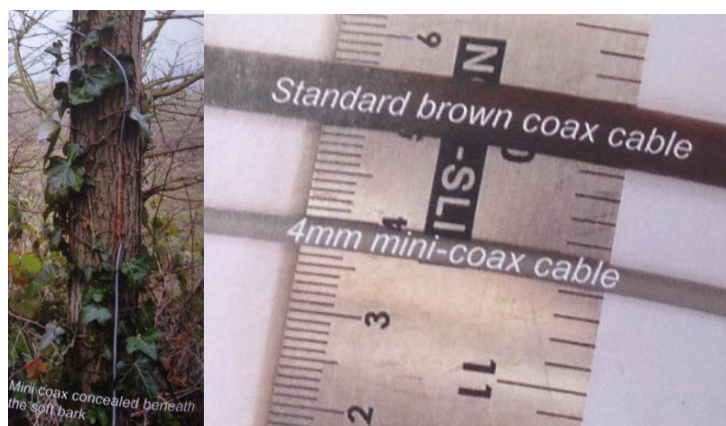
Figura 3 a) Detalle de sección de cable enmascarada bajo corteza de árbol. b) Tamaños y colores para cables apropiados.
