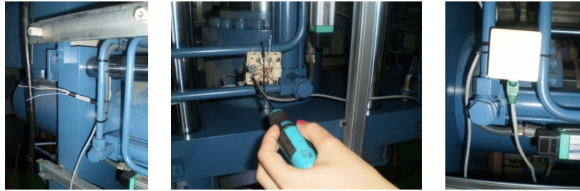
Figura iii.5. Montaje de la caja de conexiones
