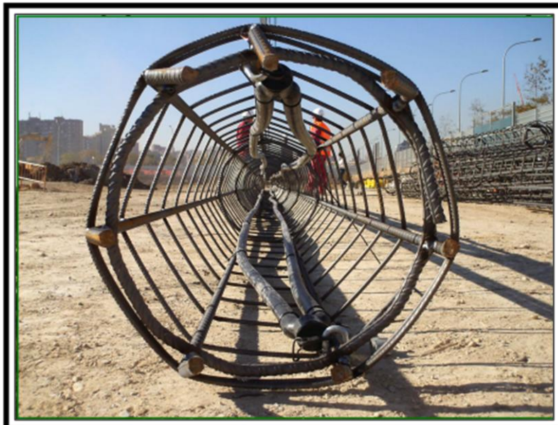
Fotografía 1: Pilote termoactivo. Fuente: Alberto Mazariegos, 2008.
