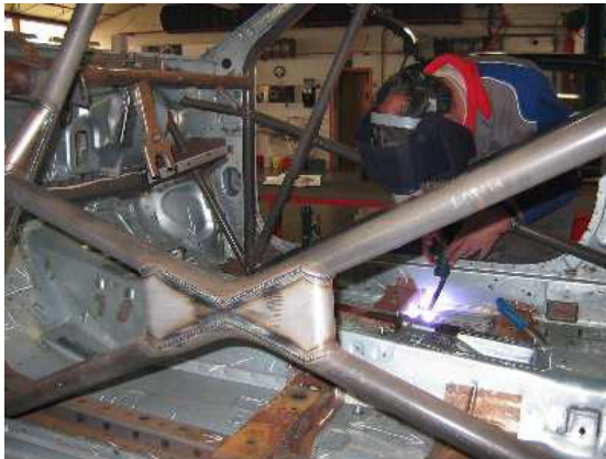
Ilustración 34 - Anclajes de los soportes de los asientos
