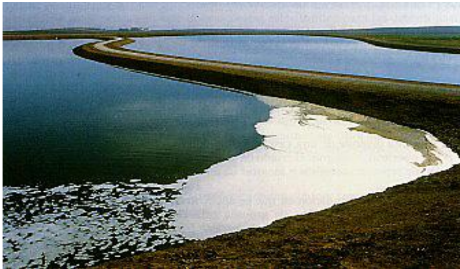
Figura A.I.1. Formación de espumas en laguna.
