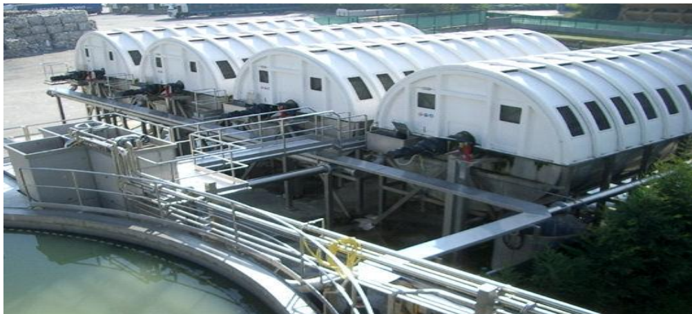
Figura 2.15 Contactores biológicos rotativos.
