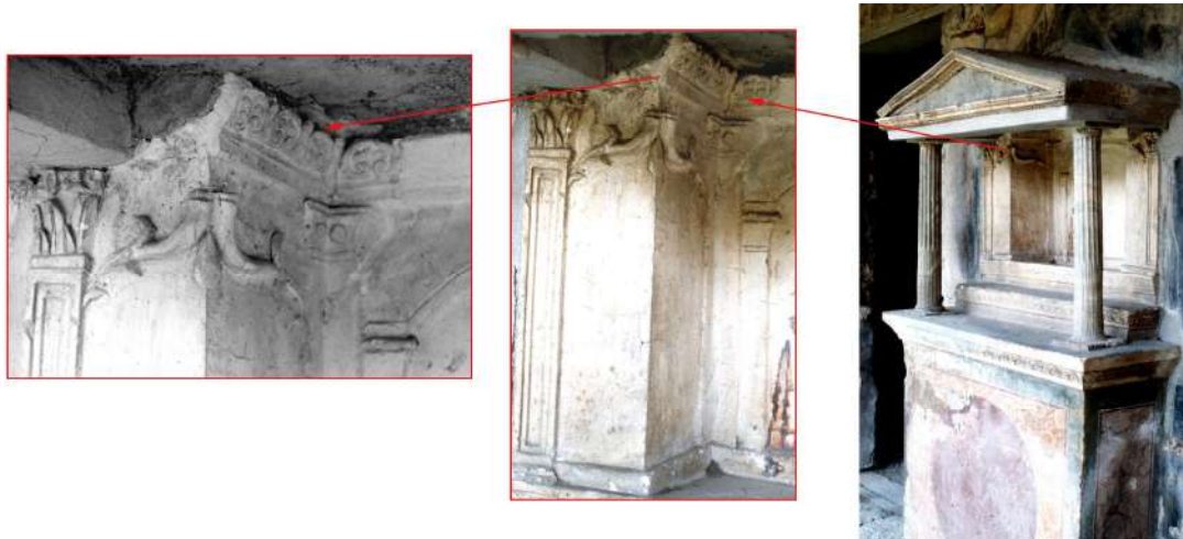
Figura 46: Larario de la Casa degli Amorini dorati (VI 16, 7-38) en Pompeya. Detalle de cómo la moldura recorre la estructura en la parte superior interna (Foto de N. Blanc)
