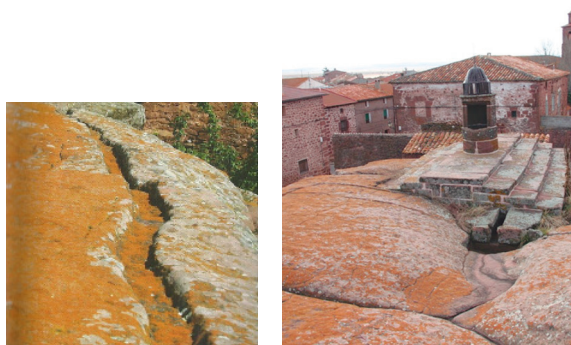
Figura 59. Sistema de canalización de agua (izquierda) y depósito externo (derecha)
