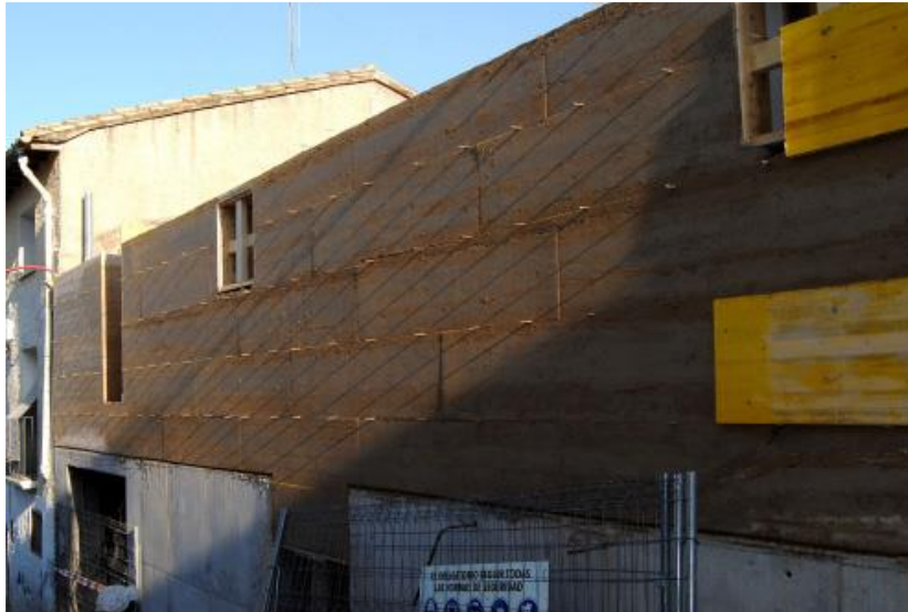
Fig.53 Construcción del muro de tapia.
