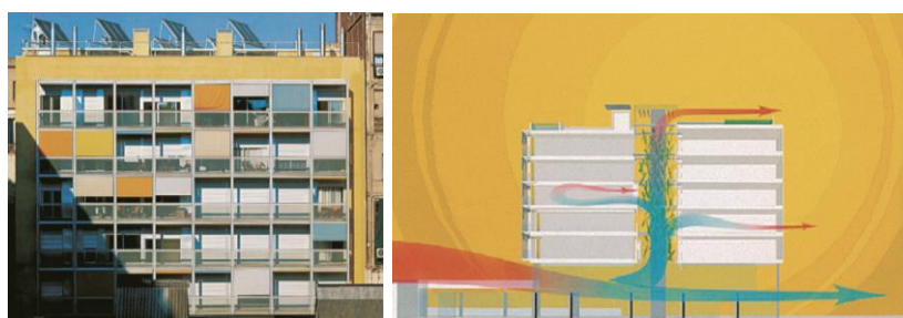
Fig.31. Ejemplo de recursos pasivos aplicados en el edificio de viviendas Pau Claris, Barcelona. Equip Arquitectura Pich- Aguilera, 2003. A la izquierda, fachada suroeste. La galería actúa como amortiguador climático. A la derecha, esquema de flujo energético estival diurno. Los vientos dominantes se canalizan en planta baja hasta el patio central del edificio introduciendo un flujo de aire fresco en el edificio.
