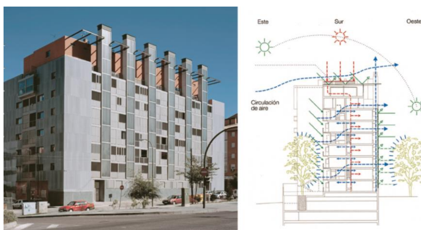
Fig.28. sección e imagen de edificio de viviendas en Madrid equipado con un sistema de enfriamiento pasivo mediante chimeneas por convección forzada con muros Trombe. M. Muelas y A. Mateo, 2004. Fuente: Revista tectónica 14.
