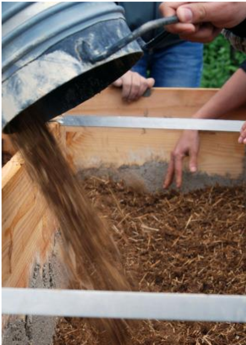
Fig.54 Puesta en obra de los materiales. Mezcla de tierra y paja en el encofrado.
