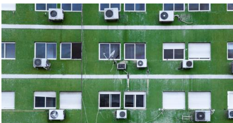
Fig.30. Fachada de un edificio de viviendas en Sevilla. Un diseño y una construcción inapropiados desde el punto de vista energético hizo que el consumo de energía dedicado a la climatización creciese de modo irresponsable.
