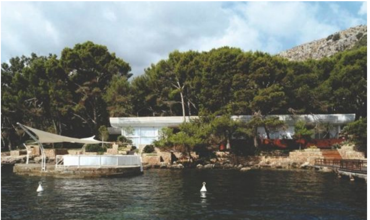
Figura 50. Fotografía: Vista desde el mar de la vivienda color.
