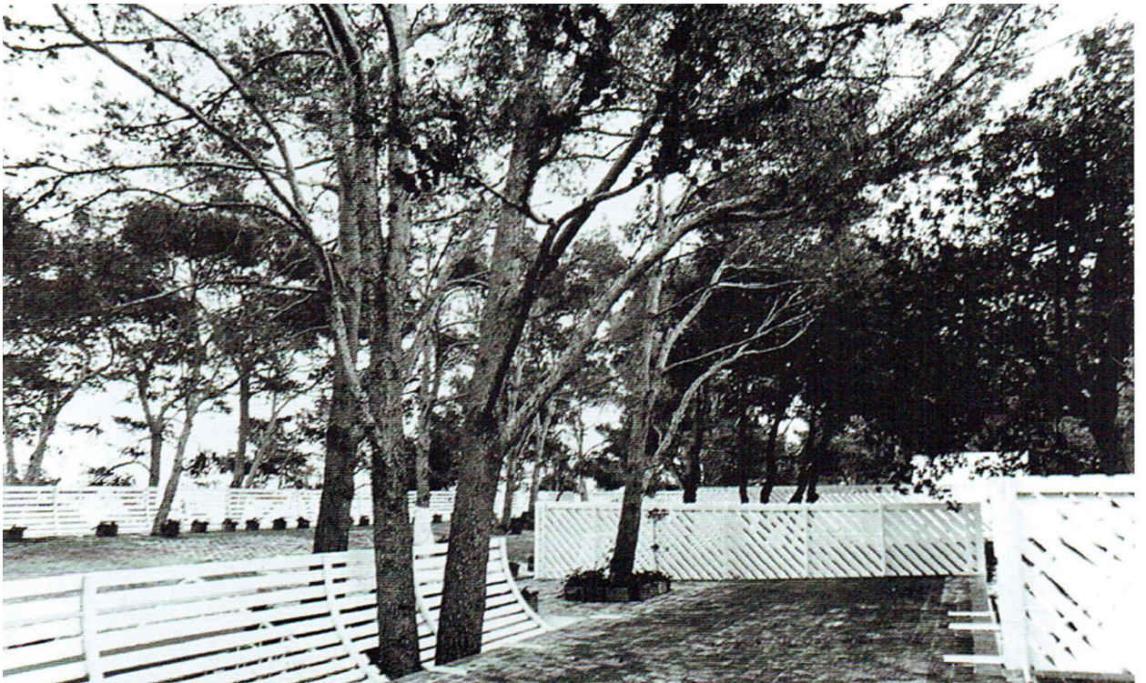
Figura 24. Fotografía: Vista cubierta.
