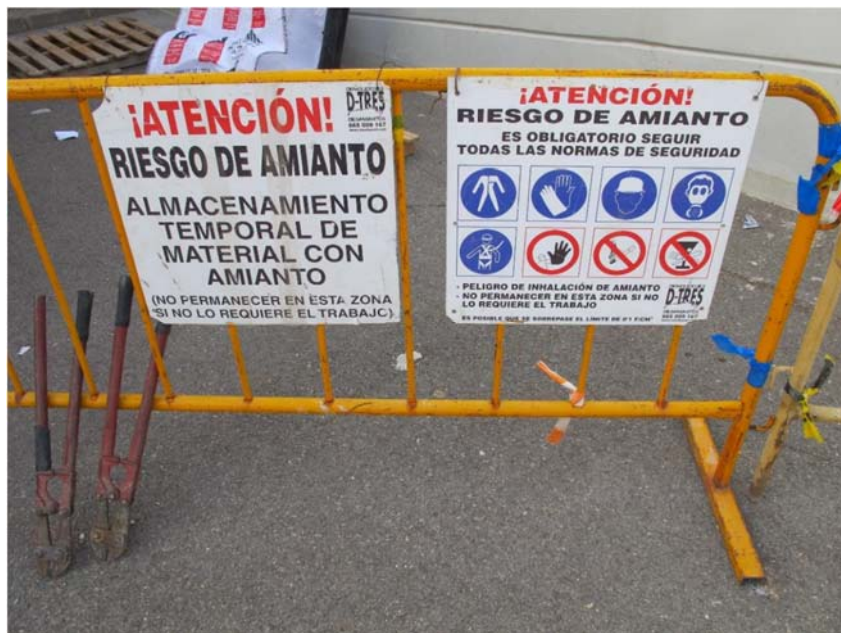
Ilustración 14 señalización de obra
