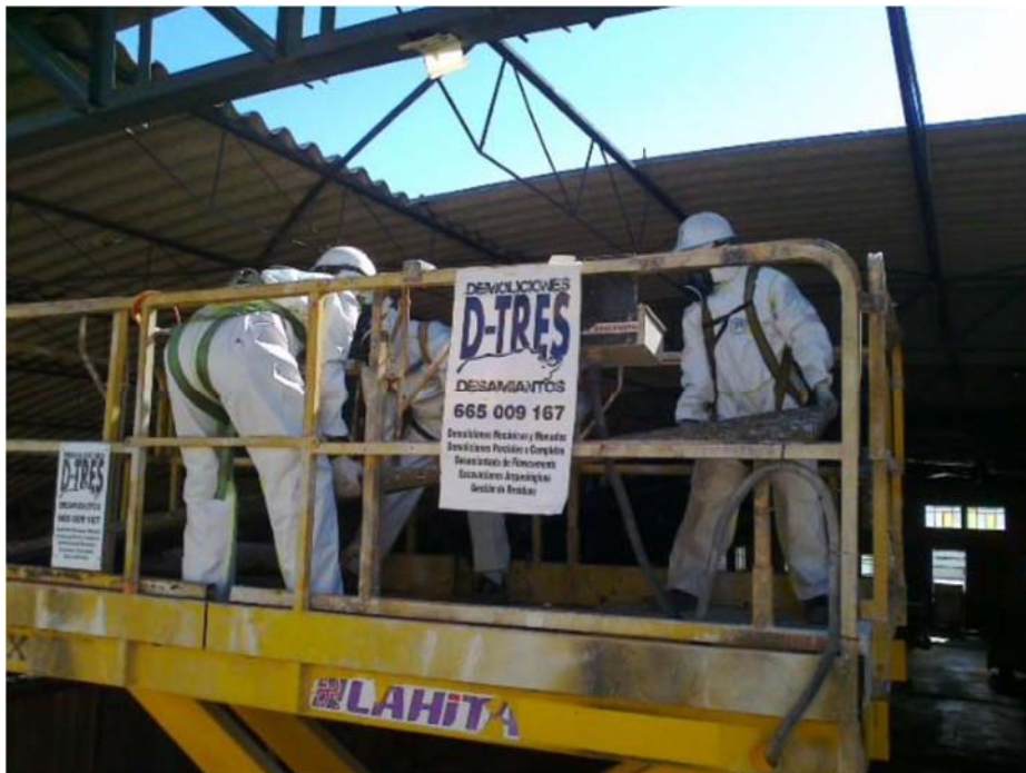
Ilustración 185 acopio sobre plataforma. Fuente: D-Tres S.L.L
