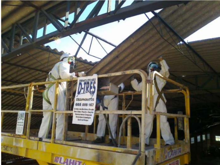
Ilustración 194 retirada de las placas. Fuente: D-Tres S.L.L
