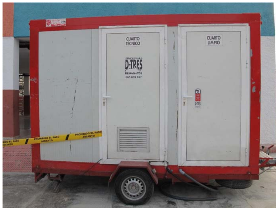
Ilustración 8 entrada al cuarto limpio, UMD
