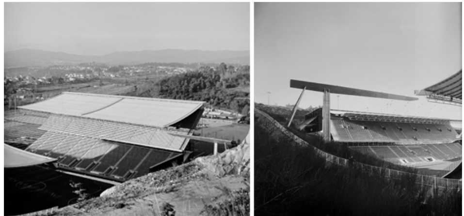
Figuras 55. Vista aérea de la cubierta y la gárgola de evacuación de lluvia Figura 56. Elementos de bajada y evacuación de lluvia.
