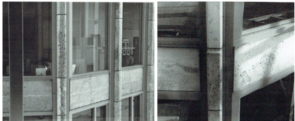
Figuras 109. Detalle de la piedra erosionada en las columnas que rematan el bloque del edificio The Economist, 1994
