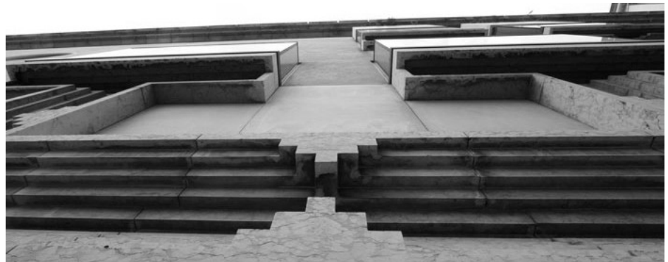
Figura 116. Detalle del remate superior del zócalo de mármol en la fachada y las bay-window
