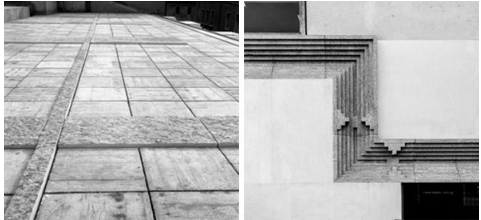
Figura 115. Detalle del remate superior del zócalo de mármol en la fachada
