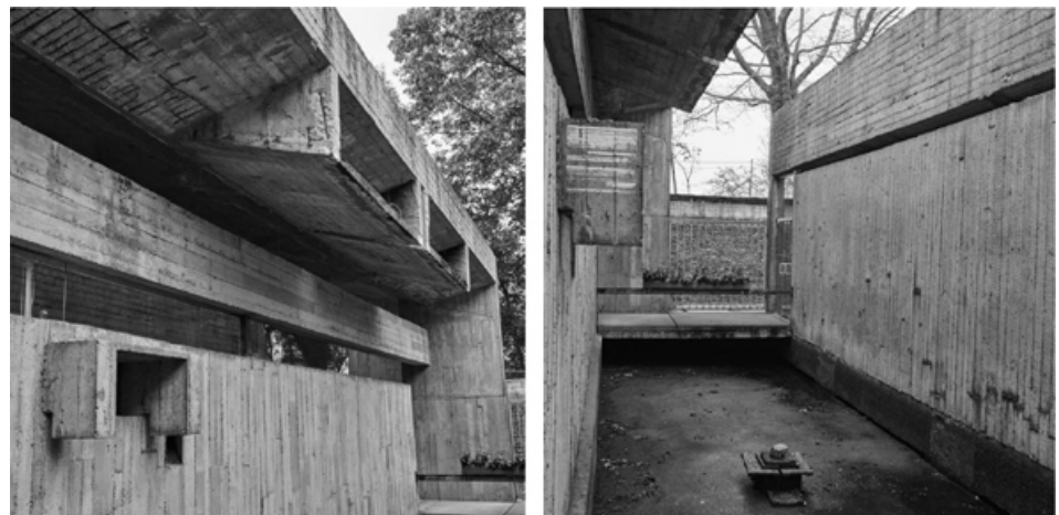
Figura 39. Detalle de la evacuación de pluviales en el patio interior. Figura 40. Vista del estanque del patio interior
