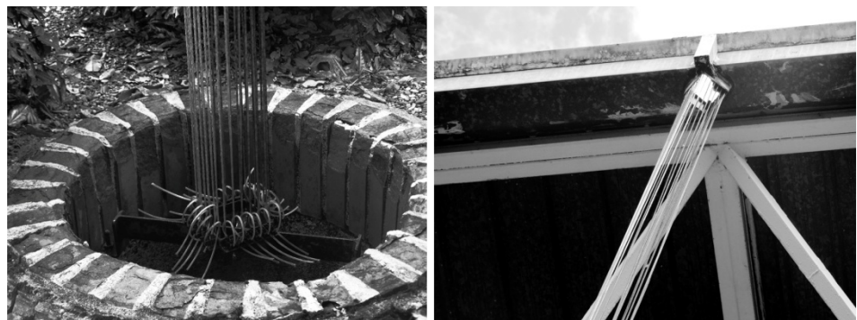
Figuras 86. Detalle de los hilos de nylon y el estanque Figuras 87. Detalle de la evacuación del agua en cubierta
