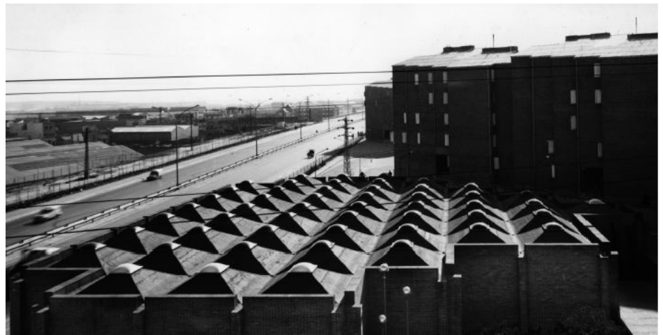
Figuras 95. Iglesia de Almendrales. Vista aérea del módulo cuadrado de cubierta y sus canalones.
