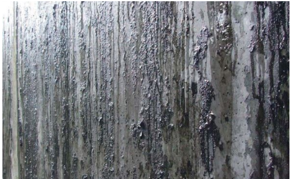
Figura 126. Detalle de la escorrentía de la lluvia en la fachada
