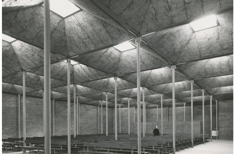
Figuras 96. Vista interior del módulo de cubierta y los pilares- Iglesia de Almendrales
