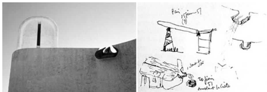
Figura 31. Vista del detalle de la Gárgola del alzado oeste. Figura 32. Croquis de la sección del tejado y la gárgola, cuaderno E18
