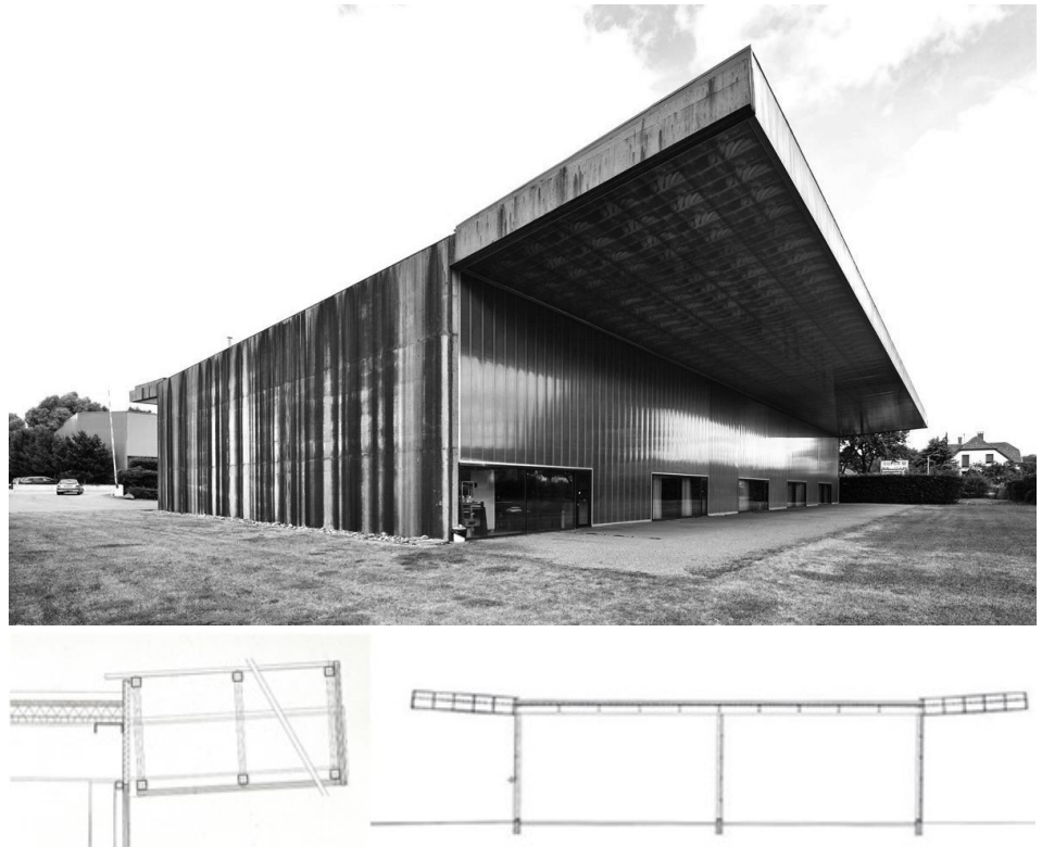
Figura 121. Vista de la fachada y los voladizos de la fábrica Ricola Mulhouse Figura 122. Detalle constructivo de los voladizos en cubierta Figura 123. Sección longitudinal de la fábrica Ricola Mulhouse
