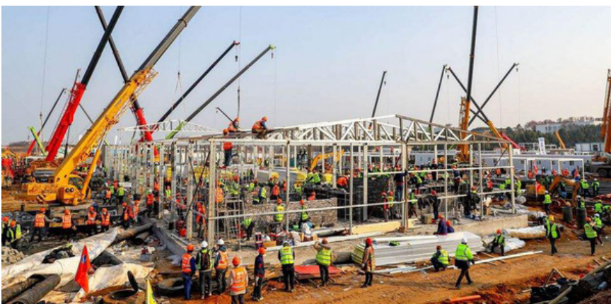
Figura 30: Día 5 de construcción del hospital Huoshenshan. Levantamiento de la estructura prefabricada de las grandes salas
