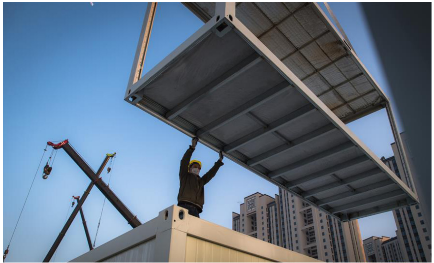
Figura 31: Colocación de los módulos tipo container en la construcción del hospital Lei-shenshan. Xinhua.
