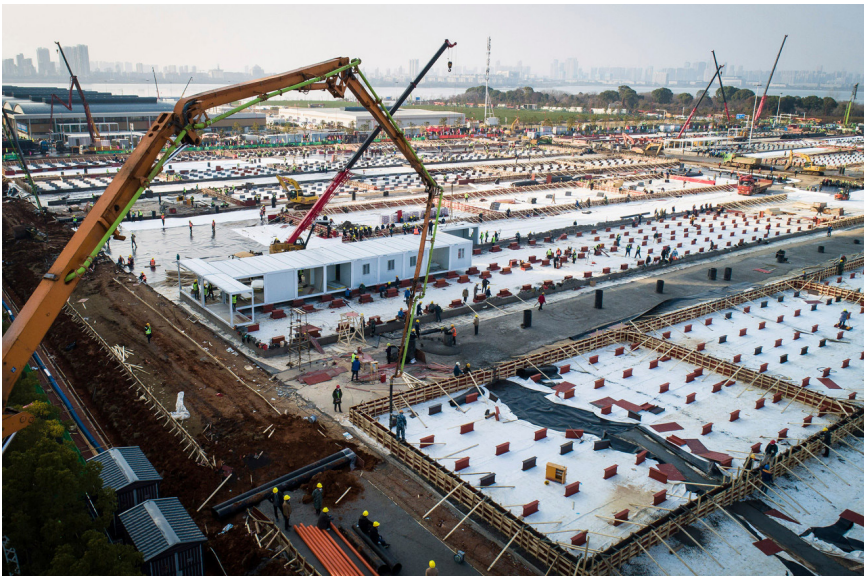
Figura 29: Foto aérea de la construcción del hospital Leishenshan, con la cimentación ejecutada.
