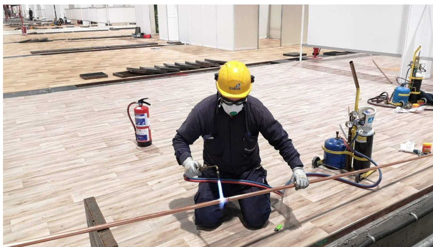
Figura 50: Un operario especializado instalando las tuberías de cobre para el oxígeno y los gases especiales necesarios en la UCI. Se puede observar el sistema de túneles subterráneos de Ifema.
