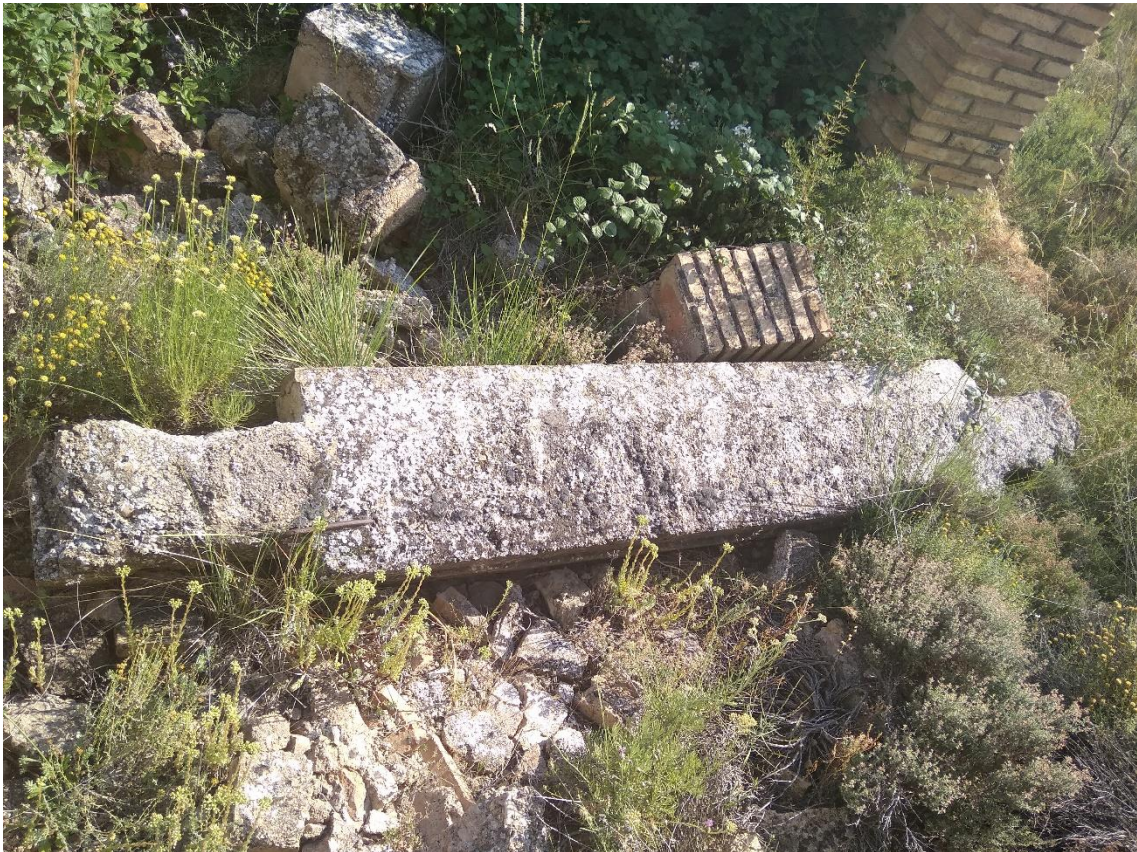
Detalle dintel hormigón, muelle de mercancías de Pitarra (Alcorisa)
