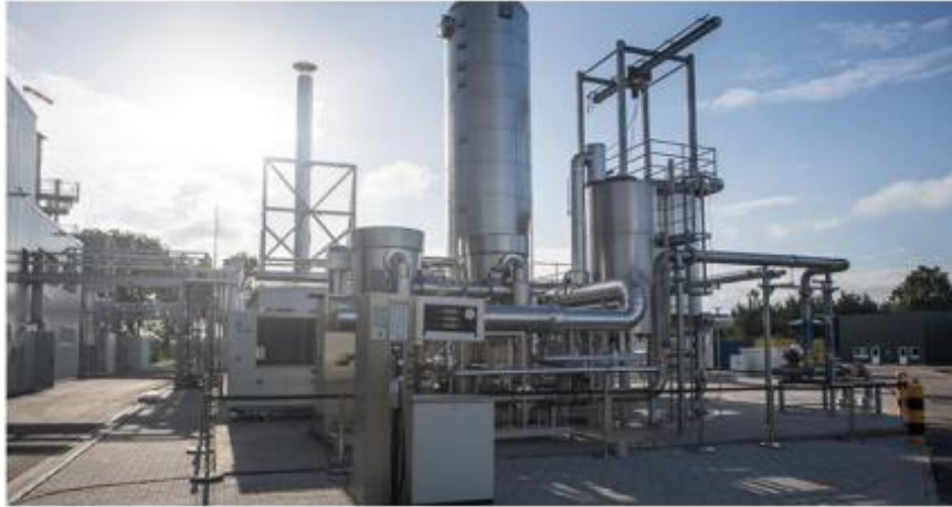
Figura 6. Planta piloto de P2G mediante hidrolisis en Werlte, Alemania [Fenosa,2017].
