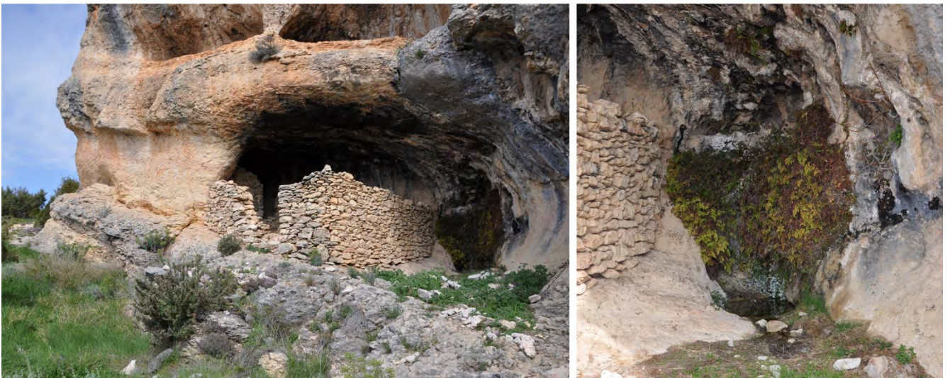
Vista general del afloramiento rocoso, con indicación de la ubicación de los abrigos (arriba); surgencia en el covacho situado entre Quizans I y Quizans II (abajo).
