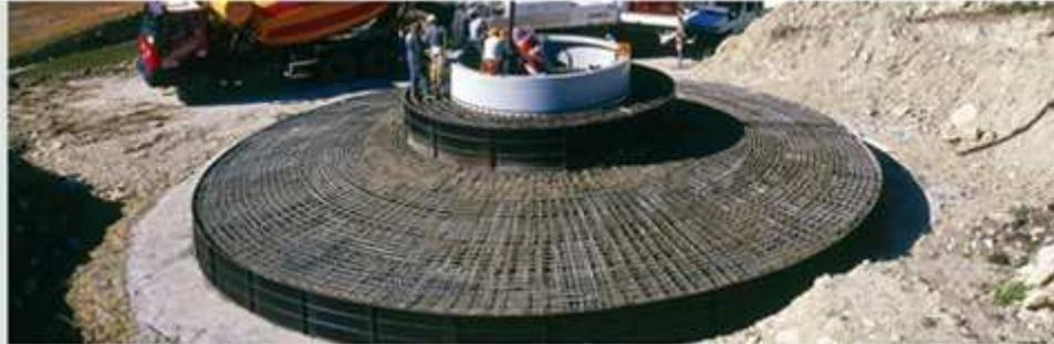
**Figura 2.2 Construcción de una zapata.**
