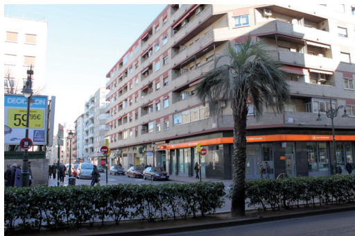
La Casa de la Galera estaba situada en el lugar que hoy ocupa un edificio de viviendas, en la esquina de la calle del Conde de Aranda con la calle de Santa Lucía.
