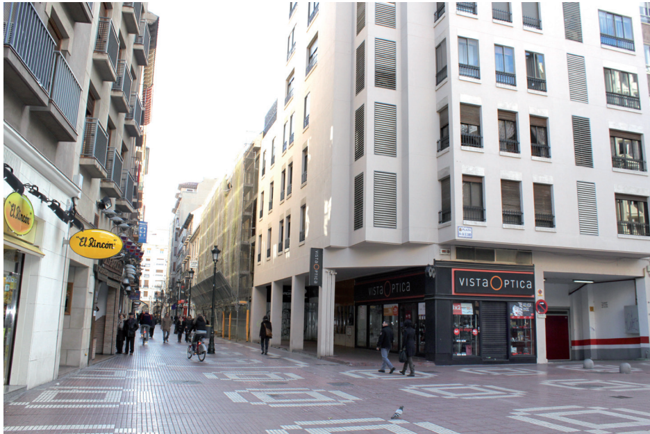
En el emplazamiento definitivo que ocuparon las Recogidas, en la esquina de la calle Cádiz con la plaza del Carmen, se levantan hoy edificios de viviendas, oficinas y el Centro Comercial El Caracol.
