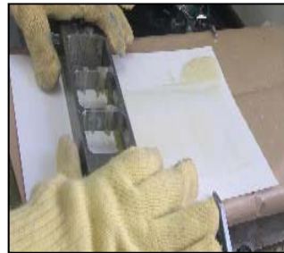
Figura 1.5: Extensión del adhesivo con capa uniforme
