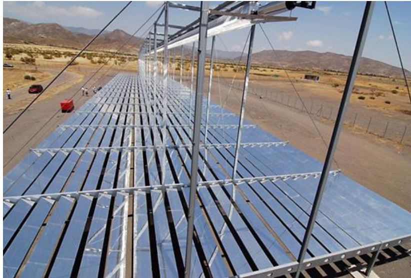
Figura 10 Reflectores lineales tipo Fresnel [18].
