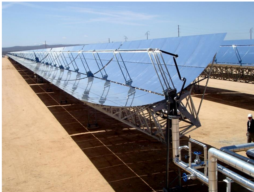
Figura 8 Central de canal parabólico [12].
