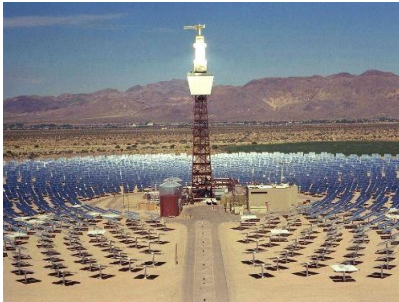
Figura 9 Torre con campo de heliostatos [8].
