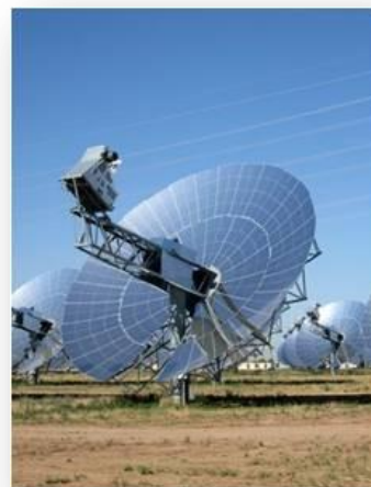
Figura 8.3: Centrales Disco-parabólicas
