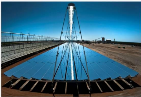
Figura 8.2: Centrales de Concentradores lineales tipo Fresnel
