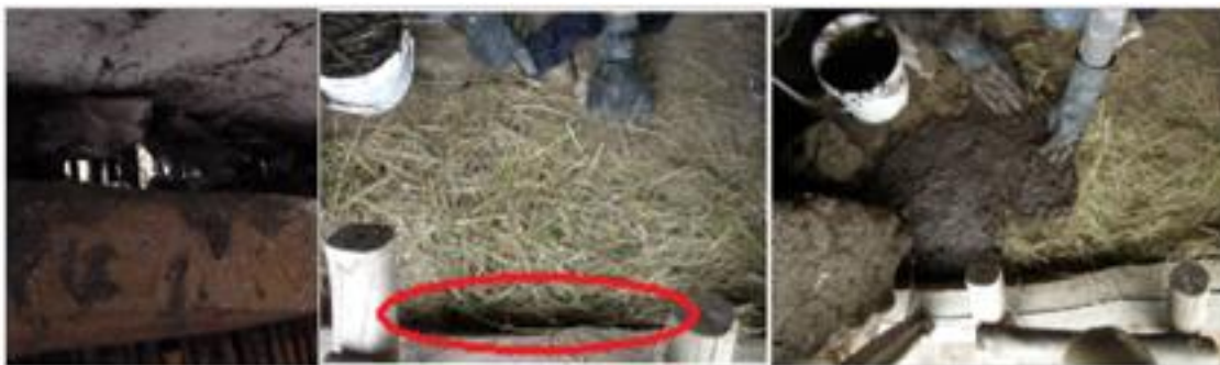
Aislamiento de grietas en el techo con barro y paja.
