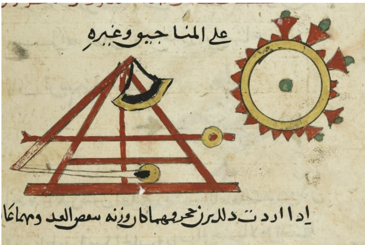
Fig III0. Manjaniq árabe de contrapeso móvil. Tratado de Nagm al-Din. BNF. Département de Manuscrits, Arabe 2825, 87v.
