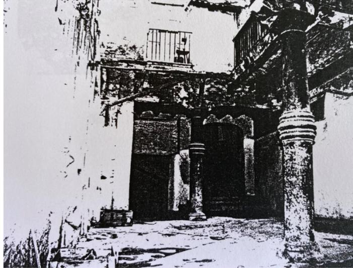
y su galería de columnitas jónicas en planta primera (si bien es preciso restituir uno de sus lados dada su inexistencia o desaparición, con el fin de igualar las cuatro caras del patio)
