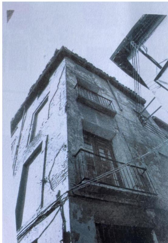
El resto, fue considerado necesario efectuarlo nuevamente: básicamente la estructura de vuelo del edificio y sus forjados, si bien no lo llamaríamos de nueva planta, dado que se plantea como recuperación de su estructura original, aunque con sustitución de elementos.
