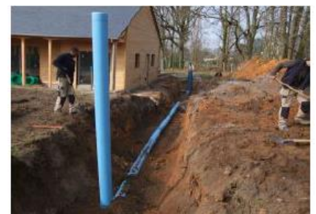
Ilustración 12-Conducto enterrado AUTOR: Eiena Aran Guillen
