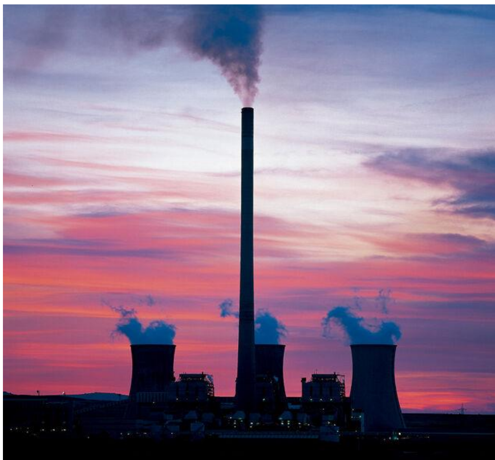
Ilustración 3: vista de la Central Térmica Teruel. Fuente: eldiario.es
