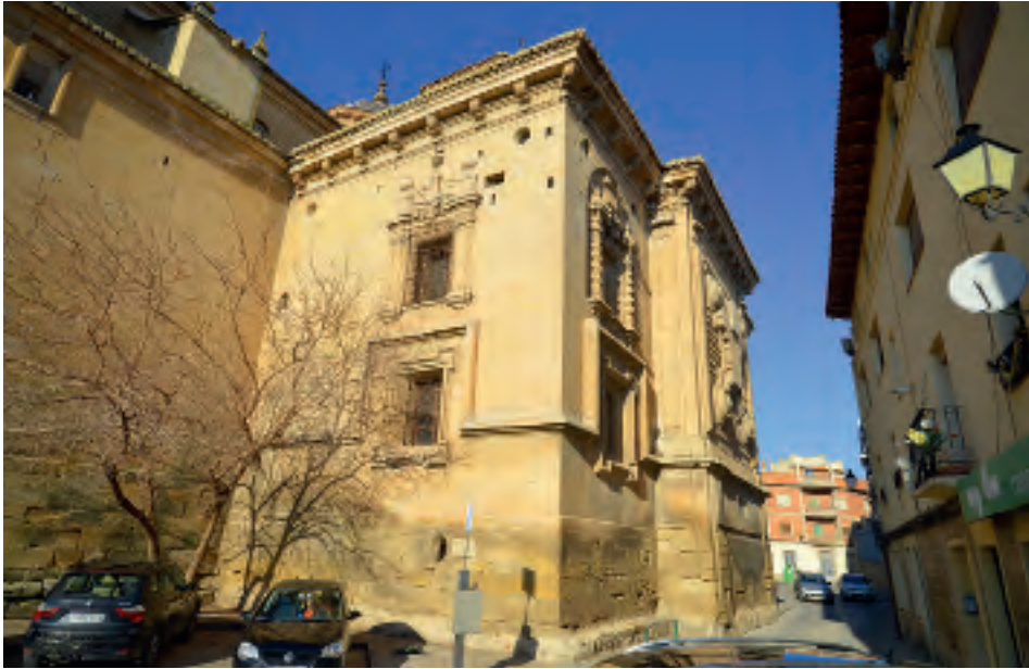
Fig. 2. Alcañiz (Teruel). Iglesia de Santa María la Mayor. Capilla de la Soledad. Exterior. Fotografía: Jorge Martín Marco.
