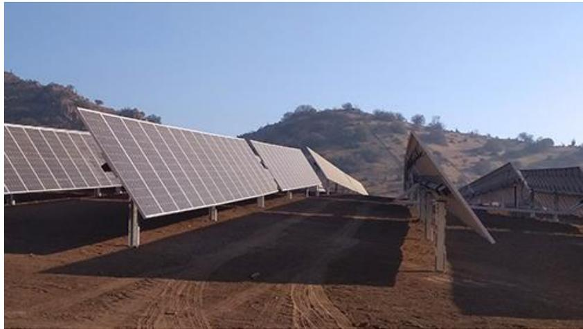
Figura 5: Seguidor Solar modelo *Sti-H250*. [5]
