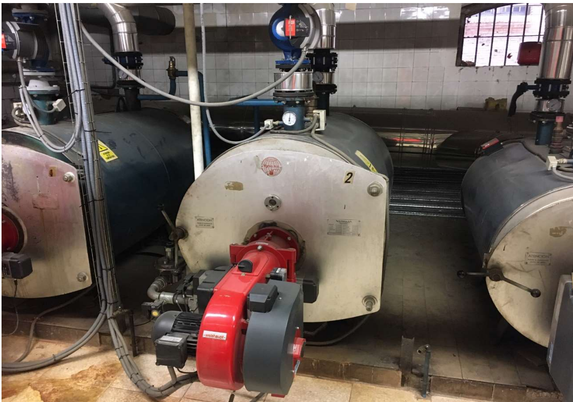
Ilustración 6 Caldera 2+quemador
