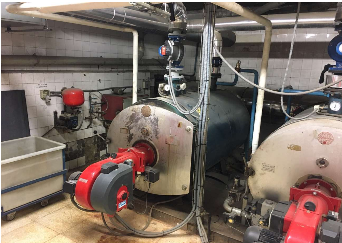
Ilustración 3 Caldera 1+quemador
