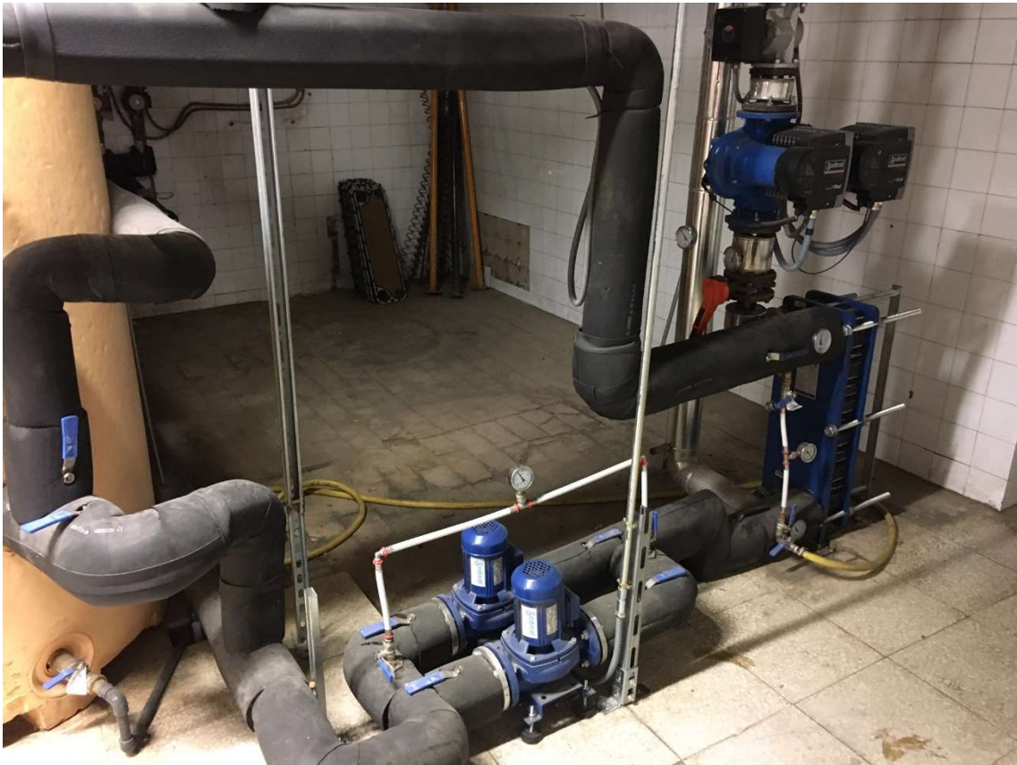
Ilustración 16 Bombas primario, secundario e intercambiador de ACS
