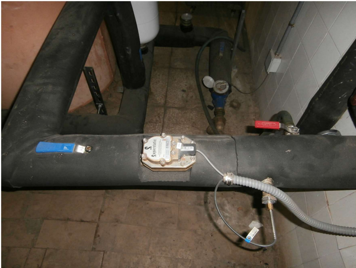
Ilustración 24 Contador térmico recirculación ACS
