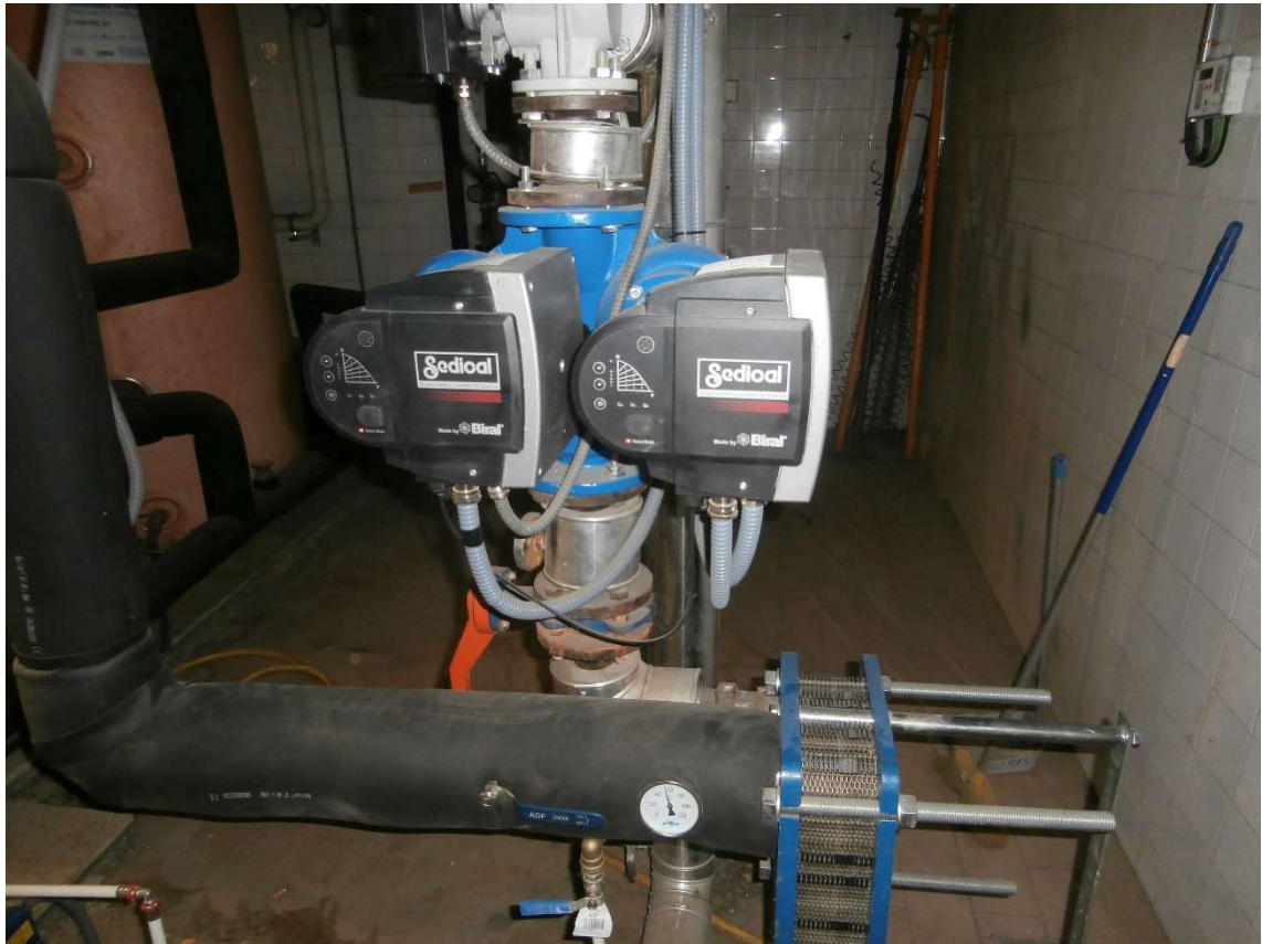
Ilustración 18 Bomba rotor húmedo primario ACS
