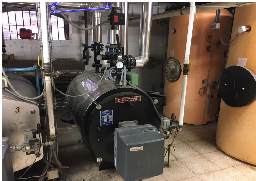
Ilustración 12 Caldera 4+quemador
