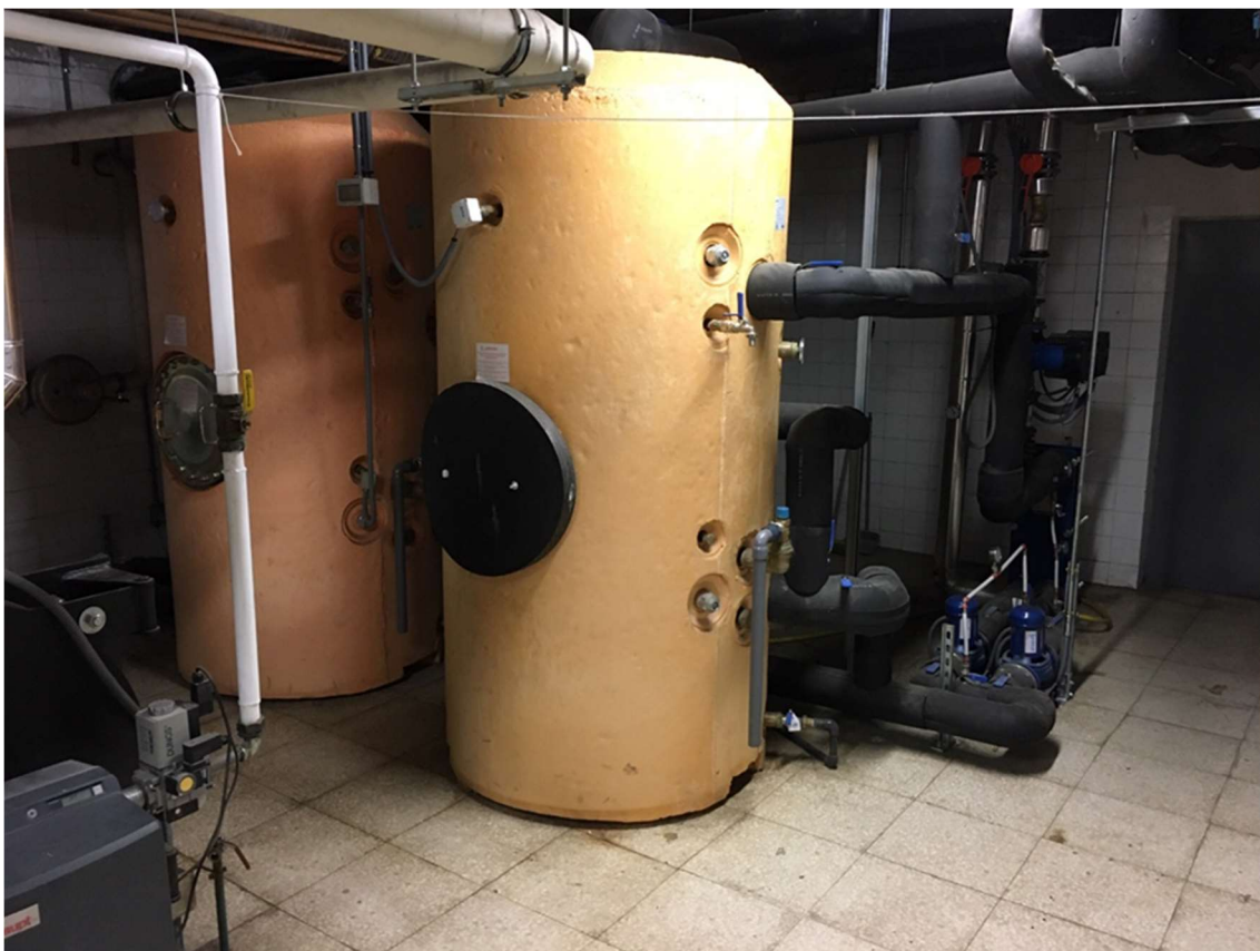
Ilustración 20 Depósitos acumulación
