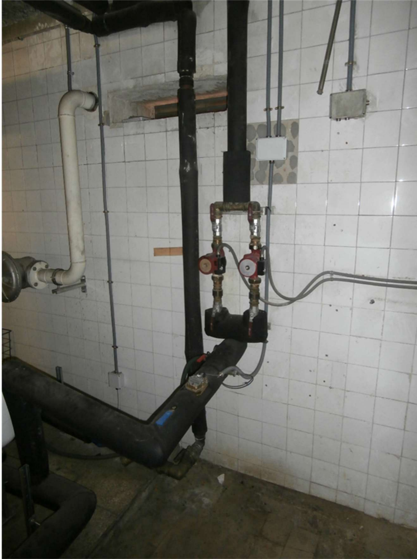
Ilustración 23 Bombas recirculación ACS
