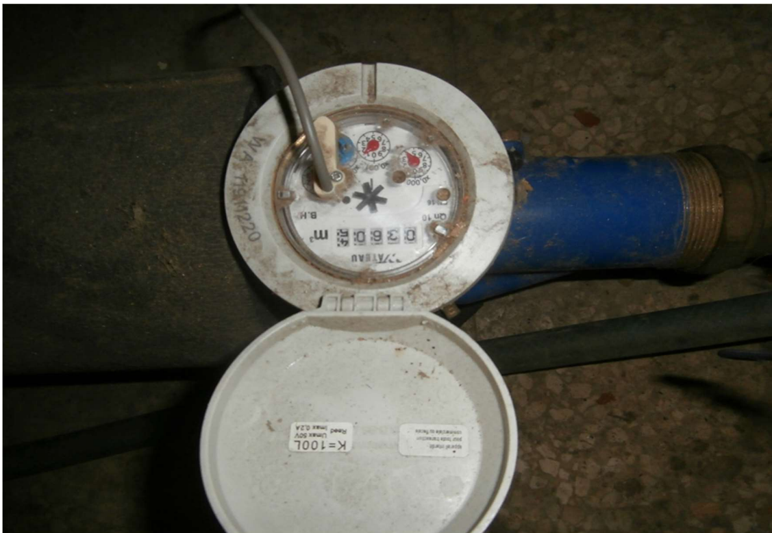
Ilustración 25 Contador agua fría entrada ACS
