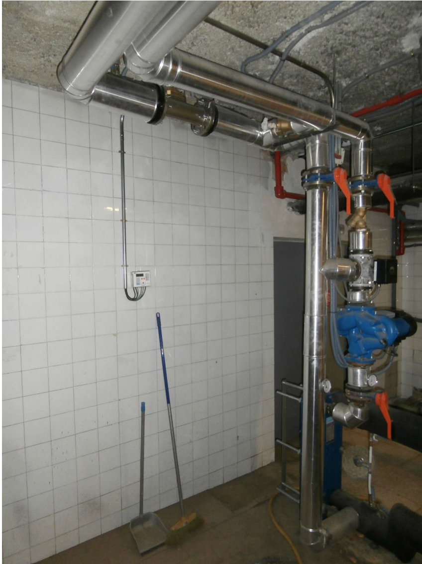
Ilustración 19 Contador térmico primario ACS
