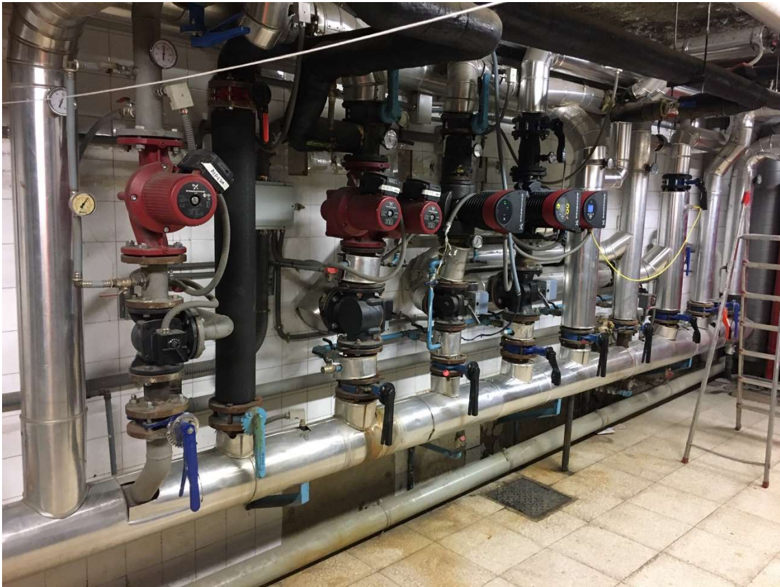
Ilustración 2 Circuitos calefacción
