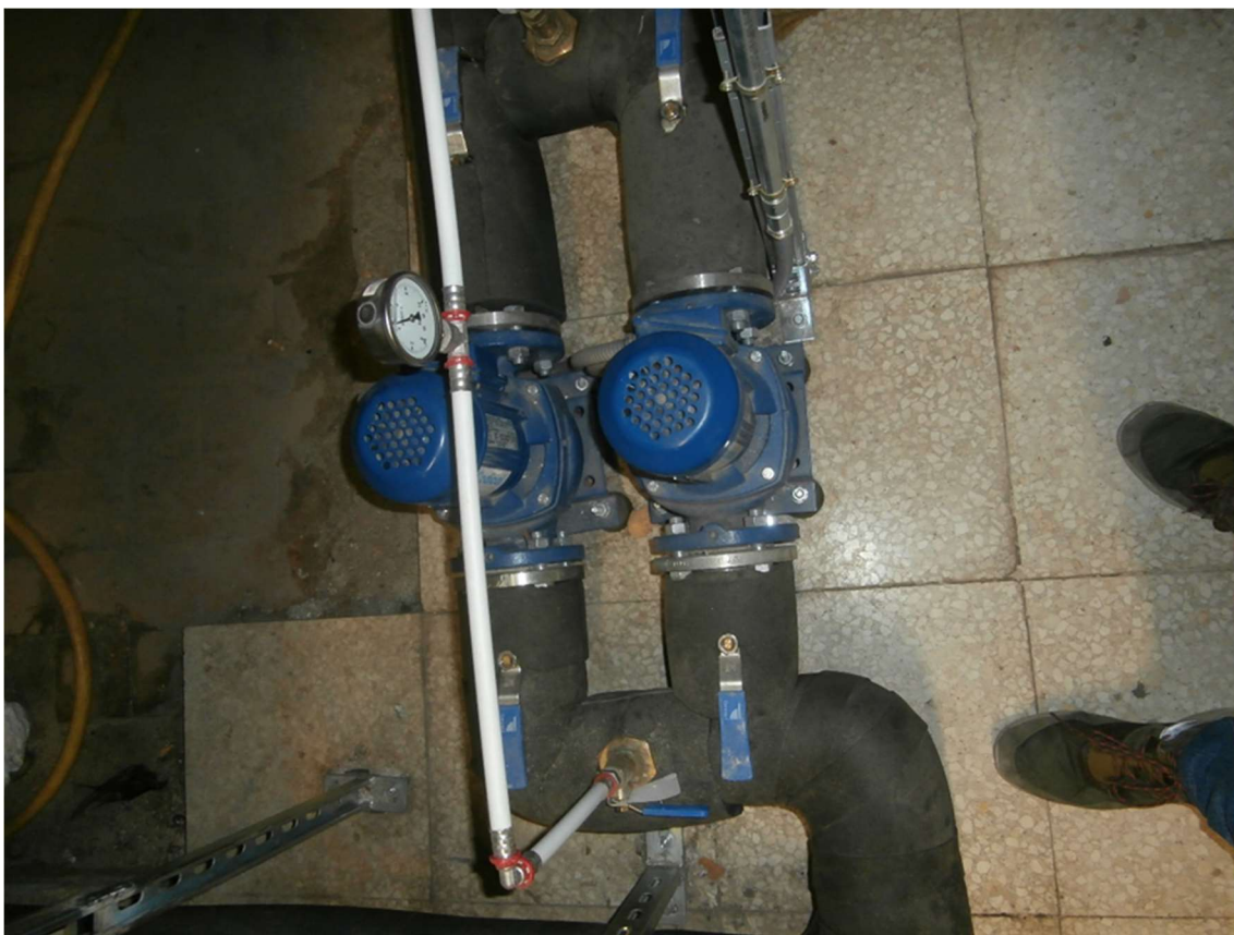
Ilustración 21 Bomba de carga secundario ACS. Rotor Seco
