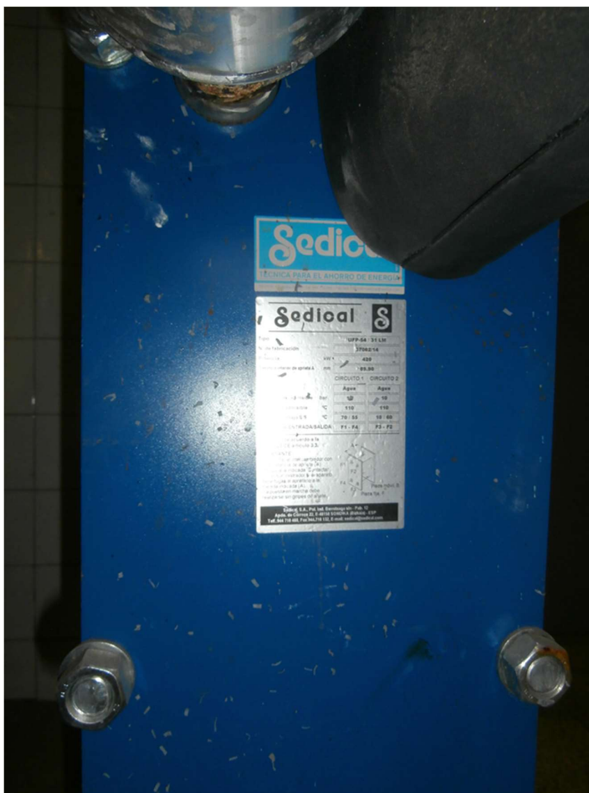
Ilustración 17 Intercambiador para producción ACS
