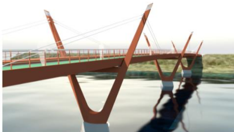
FIGURA 6. PASARELA ATIRANTADA (SALAMANCA)
