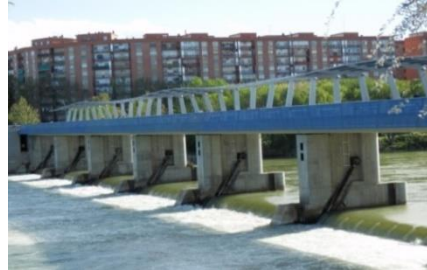
FIGURA 4. PASARELA DEL AZUD (ZARAGOZA)
