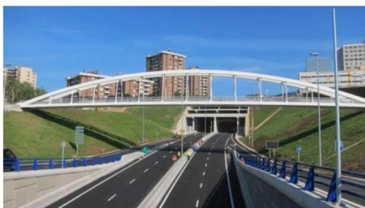
FIGURA 1. PASARELA DE ARCO Y TABLERO SUSPENDIDO (SANTANDER)
