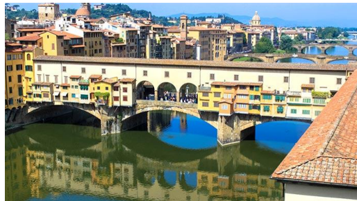
FIGURA 9. PASARELA VECCHIO (FLORENCIA)
