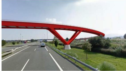
FIGURA 10. PASARELA CON VIGAS CAJÓN (SANTANDER)
