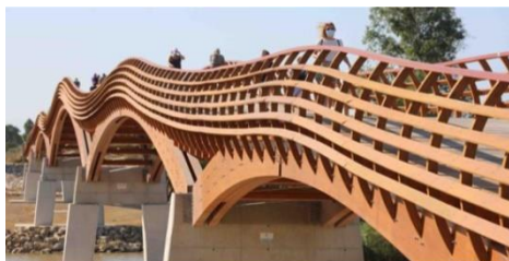
FIGURA 12. PASARELA DE MADERA
