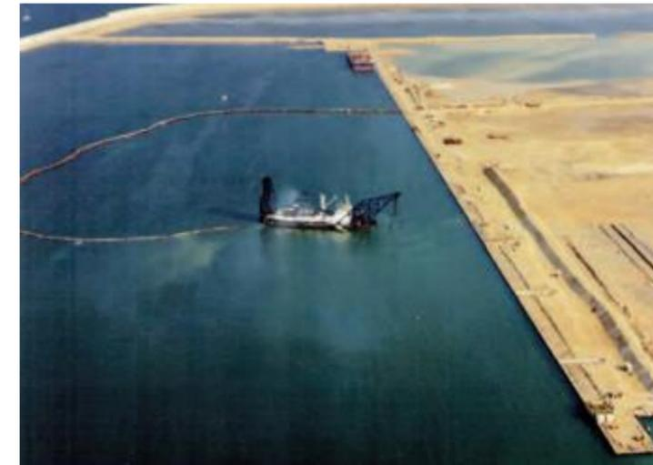
*Ilustración 2 Dragado y vertido por tubería*
