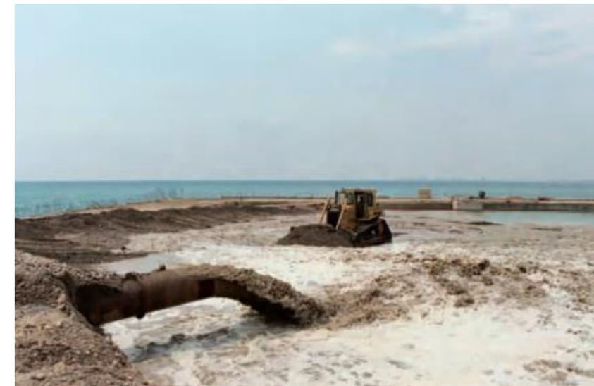
*Ilustración 1 Relleno con tubería*
