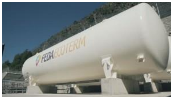
Ilustración 9. Acumulador de agua caliente [6]
