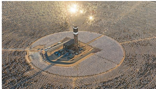
Ilustración 7. Planta de energía solar térmica concentrada [5]
