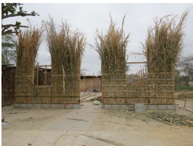
Figura 1: construcción de una vivienda típica con quincha.
