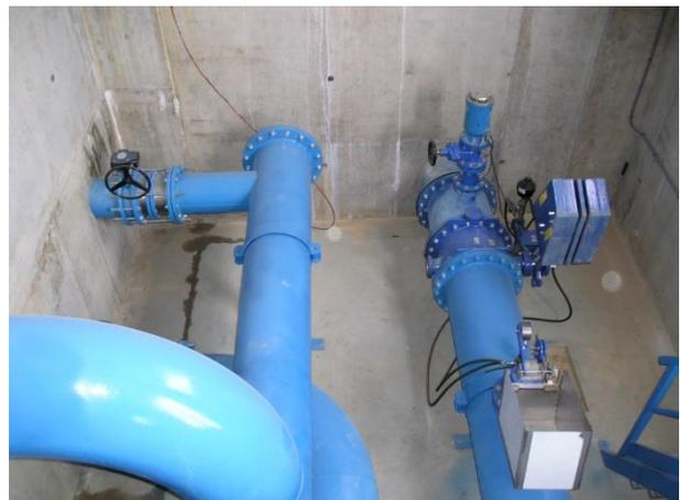
*Ilustración 4: Válvula de sobrevelocidad y ventosa en colector de salida*
