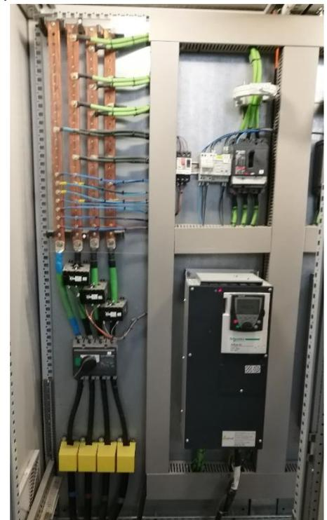
Ilustración 34: Cuadro eléctrico con la conexión de embarrado.
