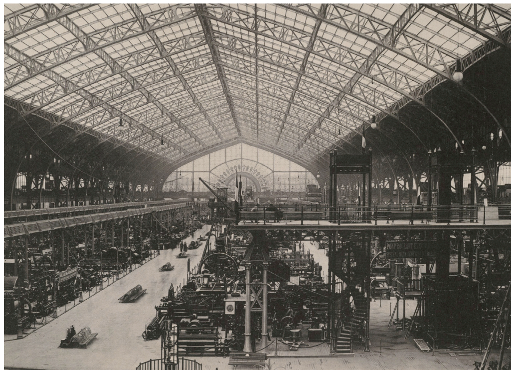
Fig. 22: Galería de las máquinas de Dutert y Contamin construida en París en 1889.
