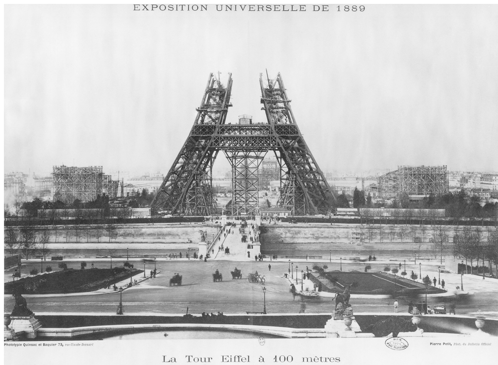
Fig. 23: Torre Eiffel de Gustave Eiffel en construcción en París en 1889. No aparecen los arcos añadidos posteriormente.
