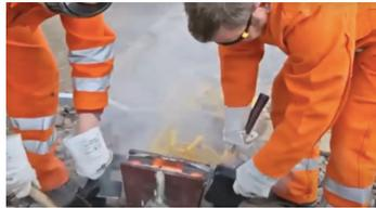
*Figura 1.13. Una vez ha tenido lugar la reacción aluminotérmica, hay que fusionar el tapón especial termosensible para que la colada del acero producido fluya al interior de los moldes que están colocados en la parte inferior.*
