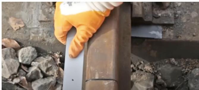
Figura 1.7. Alineación de los carriles a ser soldados y sujeción firme de los mismos a la bancada.
