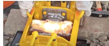
*Figura 1.14. Dada por concluida la colada del acero, hay que rebosar el exceso de acero y de escoria (óxido de aluminio). Podemos ver al operario rebosando el acero.*
