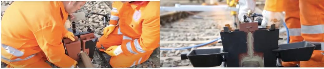
*Figura 1.8. Moldes refractarios en posición, debidamente sellados con la pasta especial.*
