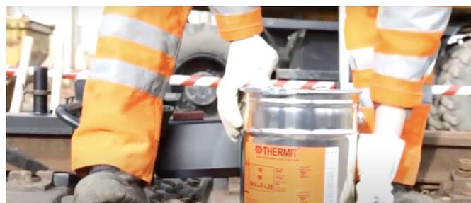
*Figura 1.11. Carga aluminotérmica para preparar la reacción.*
