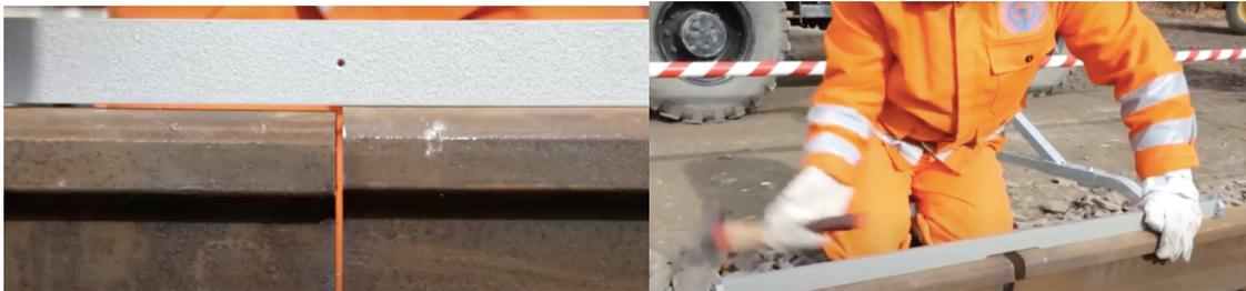
Figura 1.6. Aproximación de los carriles que van a ser soldados y medición precisa de la *cala* (separación)
