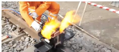
*Figura 1.9. Instalación para el pre calentamiento.*
