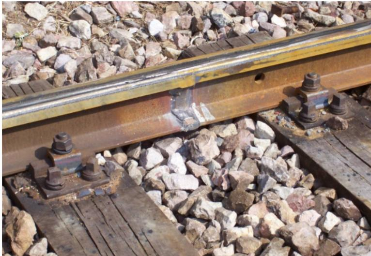
Figura 1.3. Soldadura aluminotérmica uniendo carriles.
