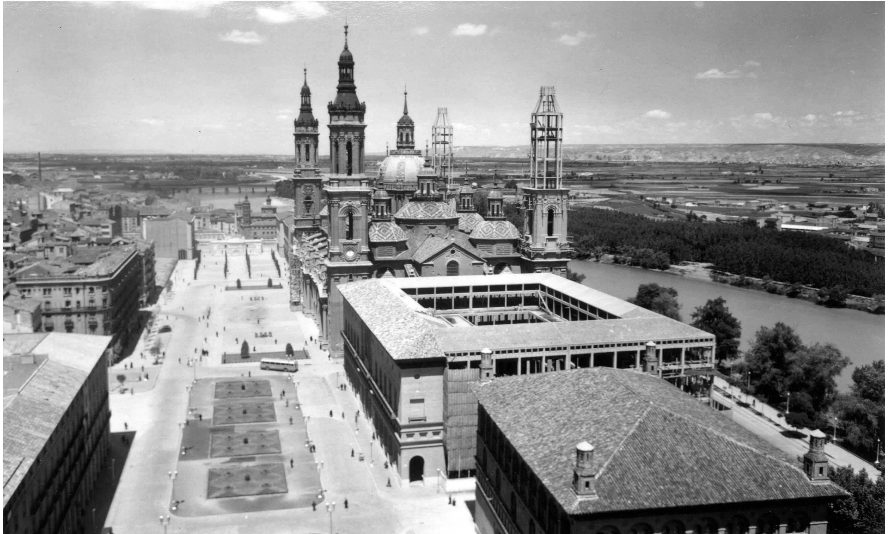
[Fig 5] Fotografía de la plaza del Pilar en proceso de transformación. Construcción de las torres de la Basílica del Pilar y del actual Ayuntamiento en 1955
