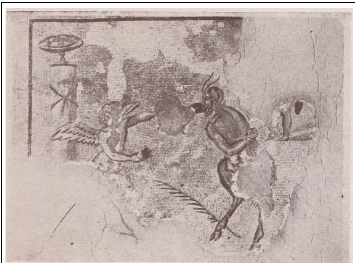
Estado de conservación en el que se encontraba el emblema de Eros y Pan previamente a su restauración en 1944 (Fuente: Galiay, 1946: lám. XXI, foto n° 40)
