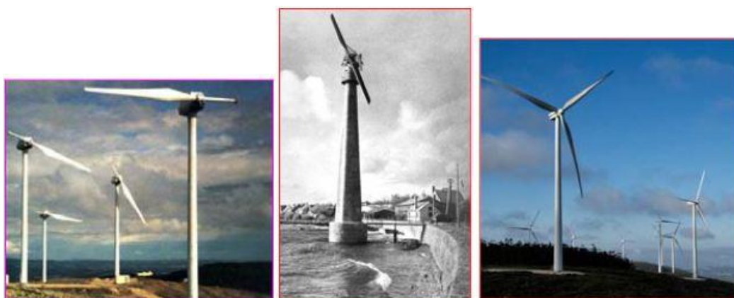
Figura 21: Eólicas rápidas. De izquierda a derecha de 1 pala, de 2 palas y de 3 palas. Fuente: www.energias-renovables.com y www.opex-energy.com
