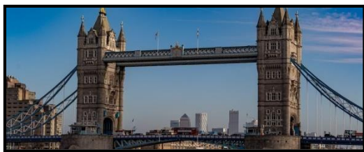
El puente de la torre
