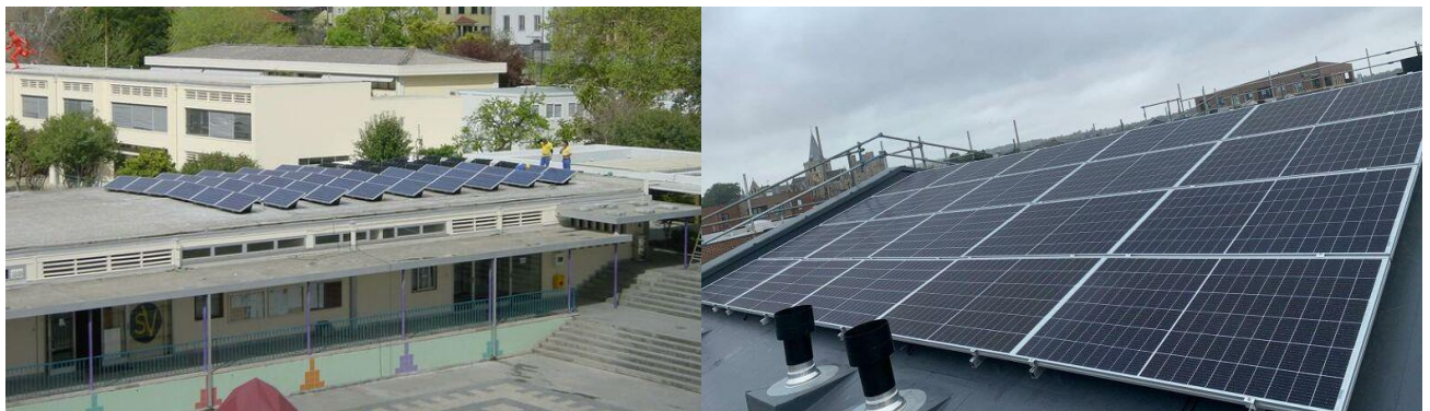
Figura 18. Colocación de placas solares según la inclinación del tejado. Fuente: Renusol.
