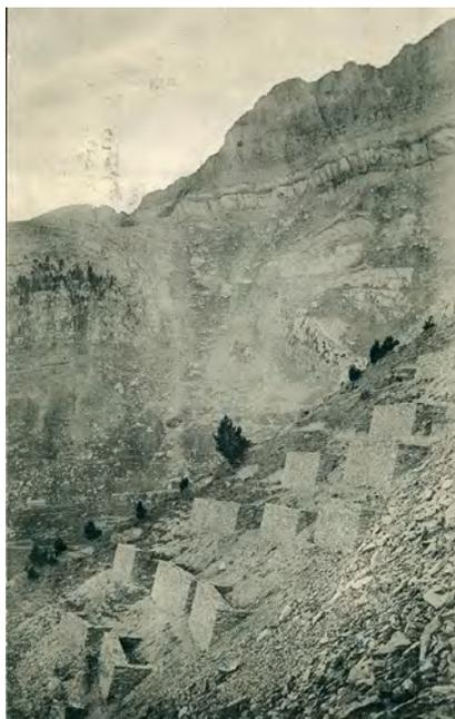
**Figura 4.** Fotografía de las obras realizadas para frenar las avalanchas y proteger la explanada.
