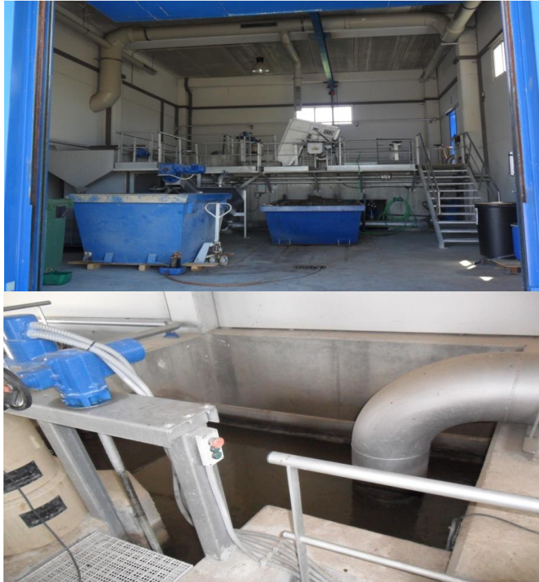
Imagen 2.13: Desbaste EDAR Tauste. Fuente: elaboración propia.
