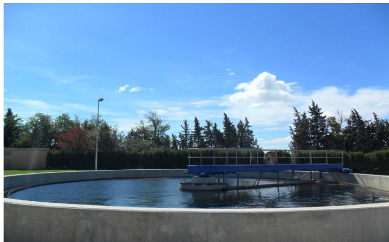
Imagen 2.17: Decantador secundario EDAR Tauste. Fuente: elaboración propia.
