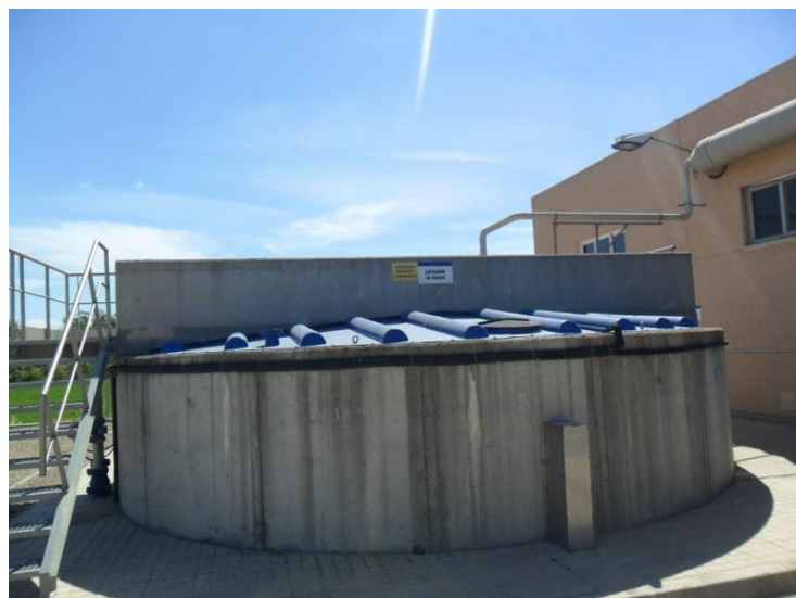
Imagen 2.19: Espesador de fangos EDAR Tauste. Fuente: elaboración propia.
