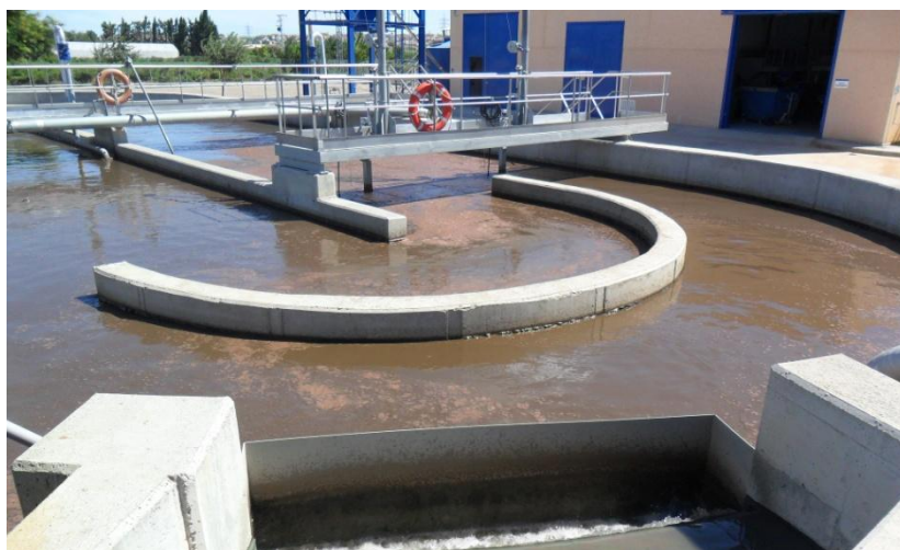
Imagen 2.16: Reactor Biológico EDAR Tauste. Fuente: elaboración propia.
