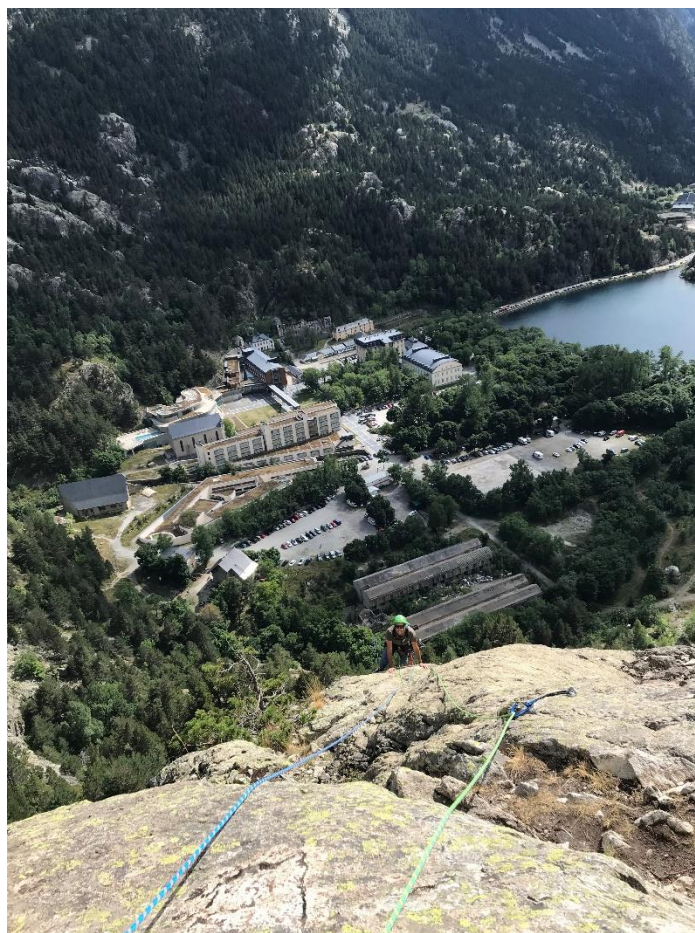
Figura 10. Vista actual del Balneario de Panticosa.
